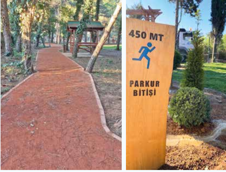
450 METRE KOŞU PARKURU - 175 METRE PARK İÇİ YOL YAPILDI.
