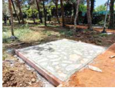
KAYRAK TAŞI UYGULAMASI
