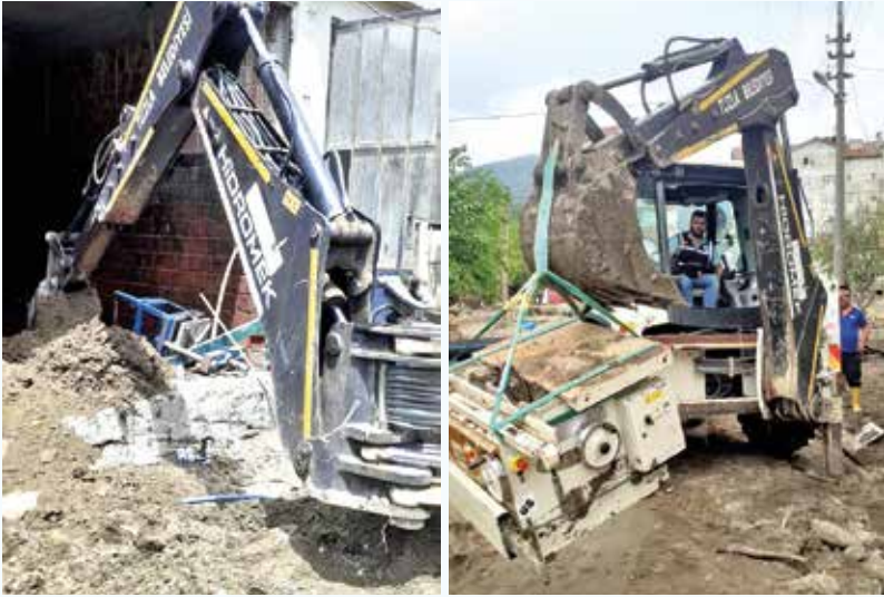
Kastamonu Bozkurt Ve Merkez Köyleri Arama Kurtarma ve Enkaz Kaldırma Çalışmaları
