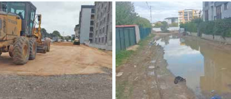
Yayla Mahallesi Nehir Sokak
