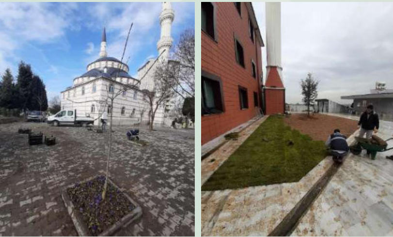
TALEPLER DOĞRULTUSUNDA 35 CAMİ BAHÇESİNDE DÜZENLEME VE BAKIM ÇALIŞMALARI YAPILMIŞTIR.
