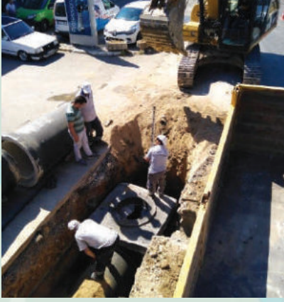
Evliya Çelebi Mahallesi Kınalıtaş Sokak Yağmur Suyu Kanal Hattı Çalışması
