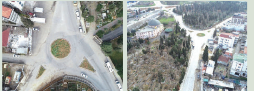
Aydınli Mahallesi Yankı Sokak Kavşak Çalışması
