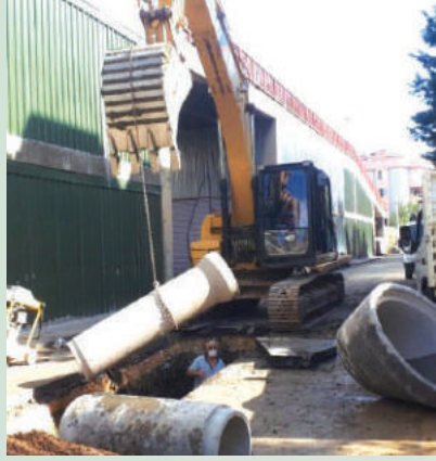
Evliya Çelebi Mahallesi Kınalıtaş Sokak Yağmur Suyu Kanal Hattı Çalışması
