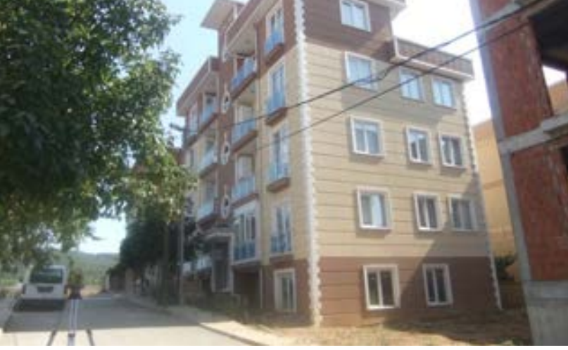
Yukardaki resimde bina ölçümü yapılmaktadır.
