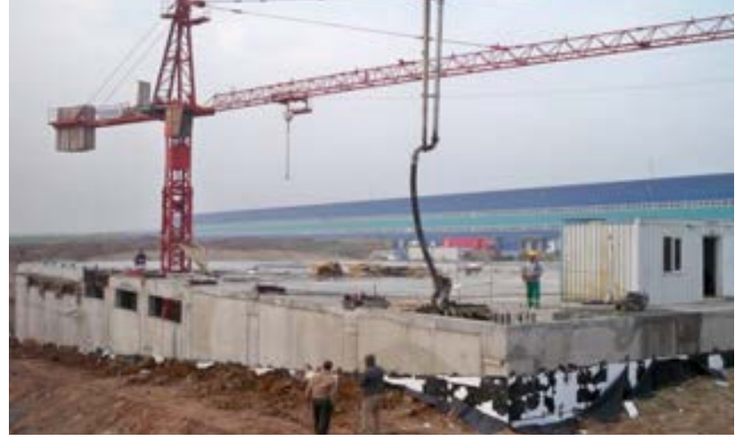
Yukardaki resimde temel üstü ruhsatı için Kontr gabari ölçümü yapılmaktadır
