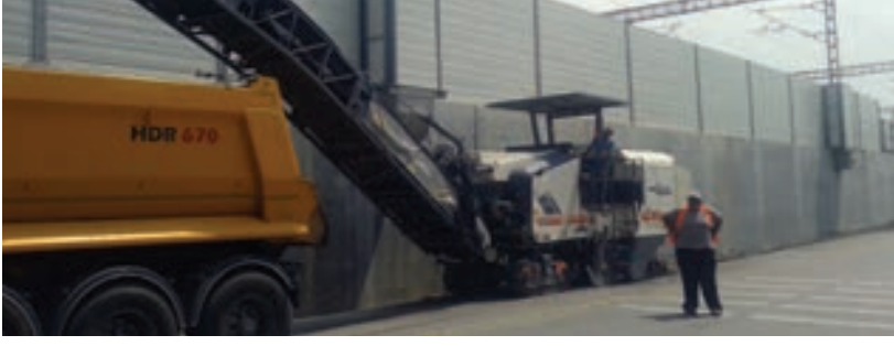
Asfalt Hazırlığı için Trimerle Kırma Çalışması
