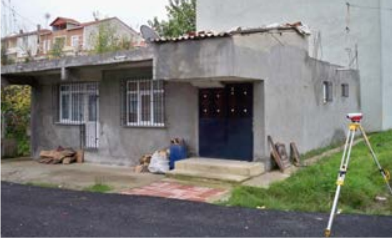
Yukardaki resimde ruhsat müracatında bulunan vatandaşa Kontr gabari vernek için ölçüm yapılmaktadır.
