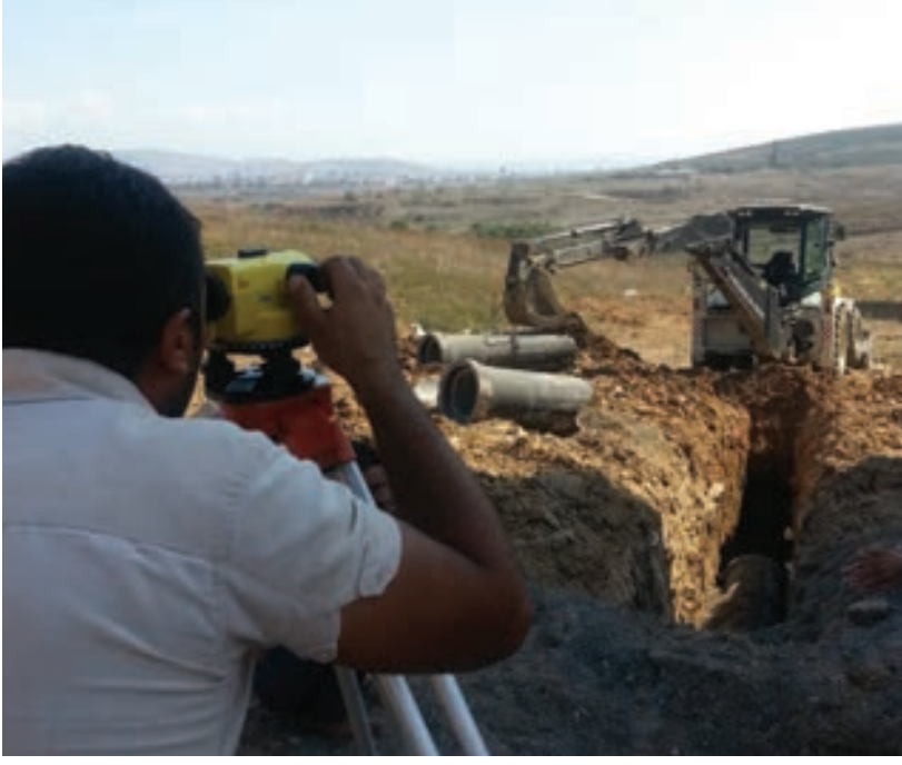
Kanal Yapım Çalışmaları
