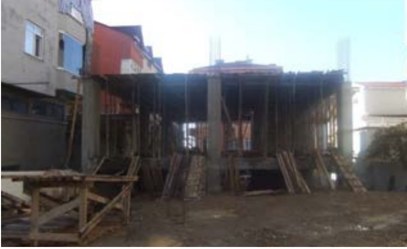
Yukardaki resimde temel üstü ruhsatı için Kontr gabari ölçümü yapılmaktadır
