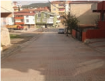
Tretuar Yol Kaplama Aydın Server Sokak
