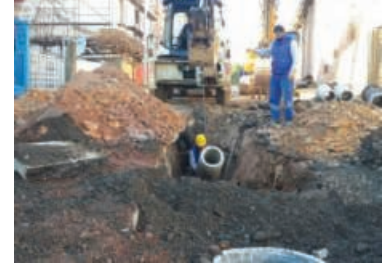
İçmeler Mahallesi Katre Sokak Ø300 mm Yağmursuyu Hattı Çalışması
