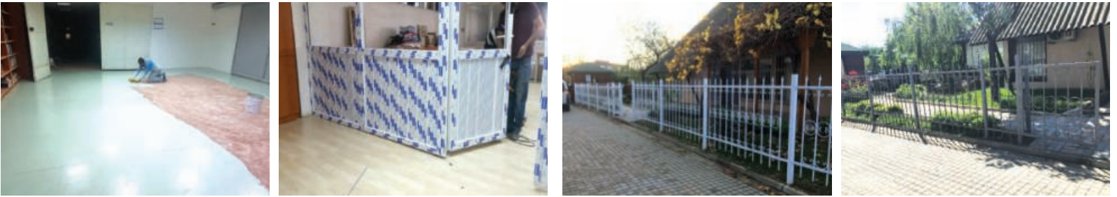
Gönül Elleri Çarşısı Zemin Kaplama Ve Bölme Duvar İmalatı
