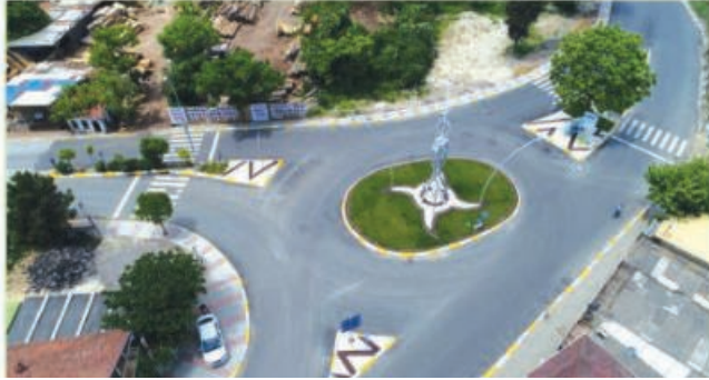
İSTASYON KAVŞAĞI SAAT KULESİ YAPIMI
