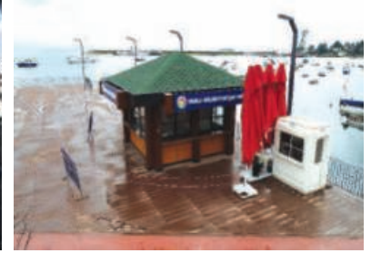
Tuzla Sahil Çay evi Yapımı
