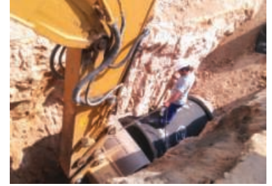
Orhanlı Mahallesi Sabancı Caddesi Ø1000 mm Yağmursuyu Hattı Çalışması
