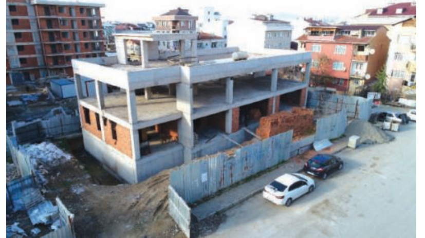
Yayla Mahallesi Muhtarlık Binası Ve Kültür Merkezi İnşaatı
