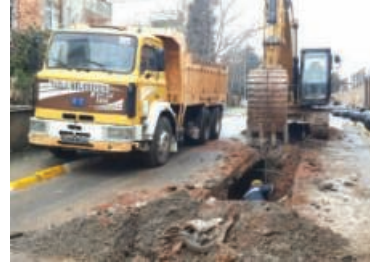
İçmeler Mahallesi Katre Sokak Ø300 mm Yağmursuyu Hattı Çalışması
