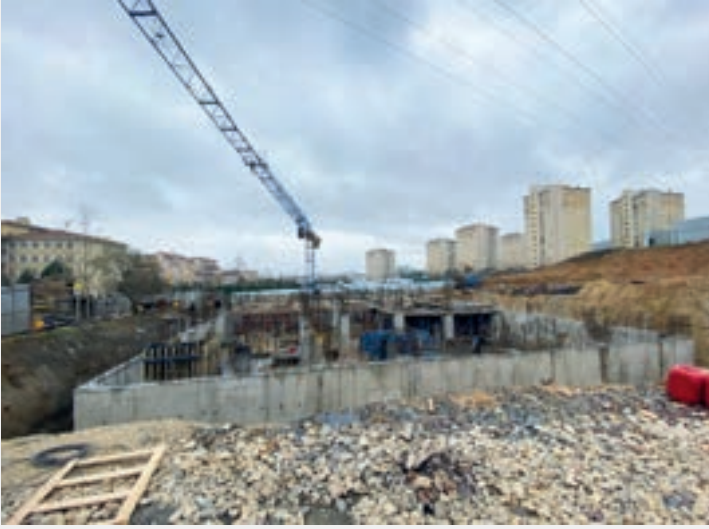
Aydınlı mahallesi-Kültür merkezi
