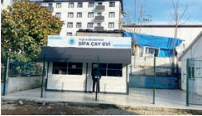
Şifa mahallesi-Çay evi
