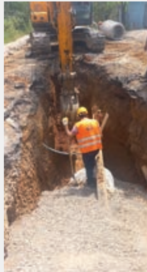
ORHANLI MAHALLESİ- Murathan caddesi
