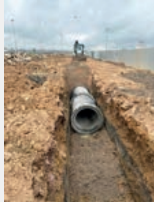
ORHANLI MAHALLESİ- Murathan caddesi
