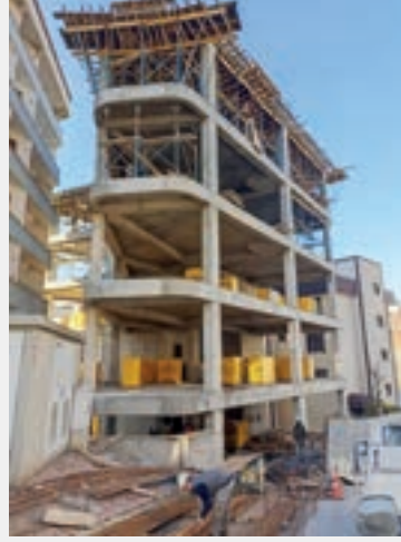
Aydıtepe mahallesi Ek hizmet binası
