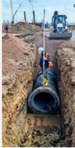
ORHANLI MAHALLESİ- Murathan caddesi
