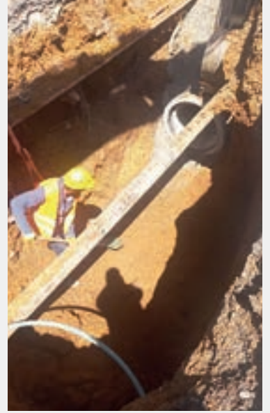
ORHANLI MAHALLESİ- Murathan caddesi
