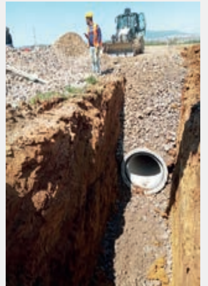
ORHANLI MAHALLESİ- Murathan caddesi
