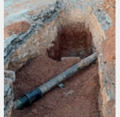
ORHANLI MAHALLESİ- Murathan caddesi
