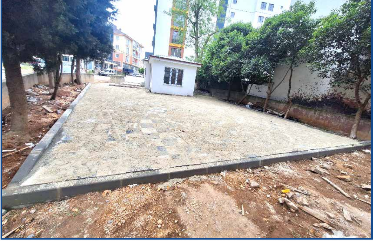
Aydınlı Mahallesi Aslı Caddesi Muhtarlık Binası
