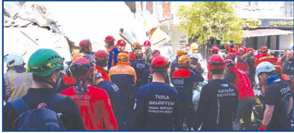
Küçük Çekmece Bina Çökmesi Destek Çalışması
