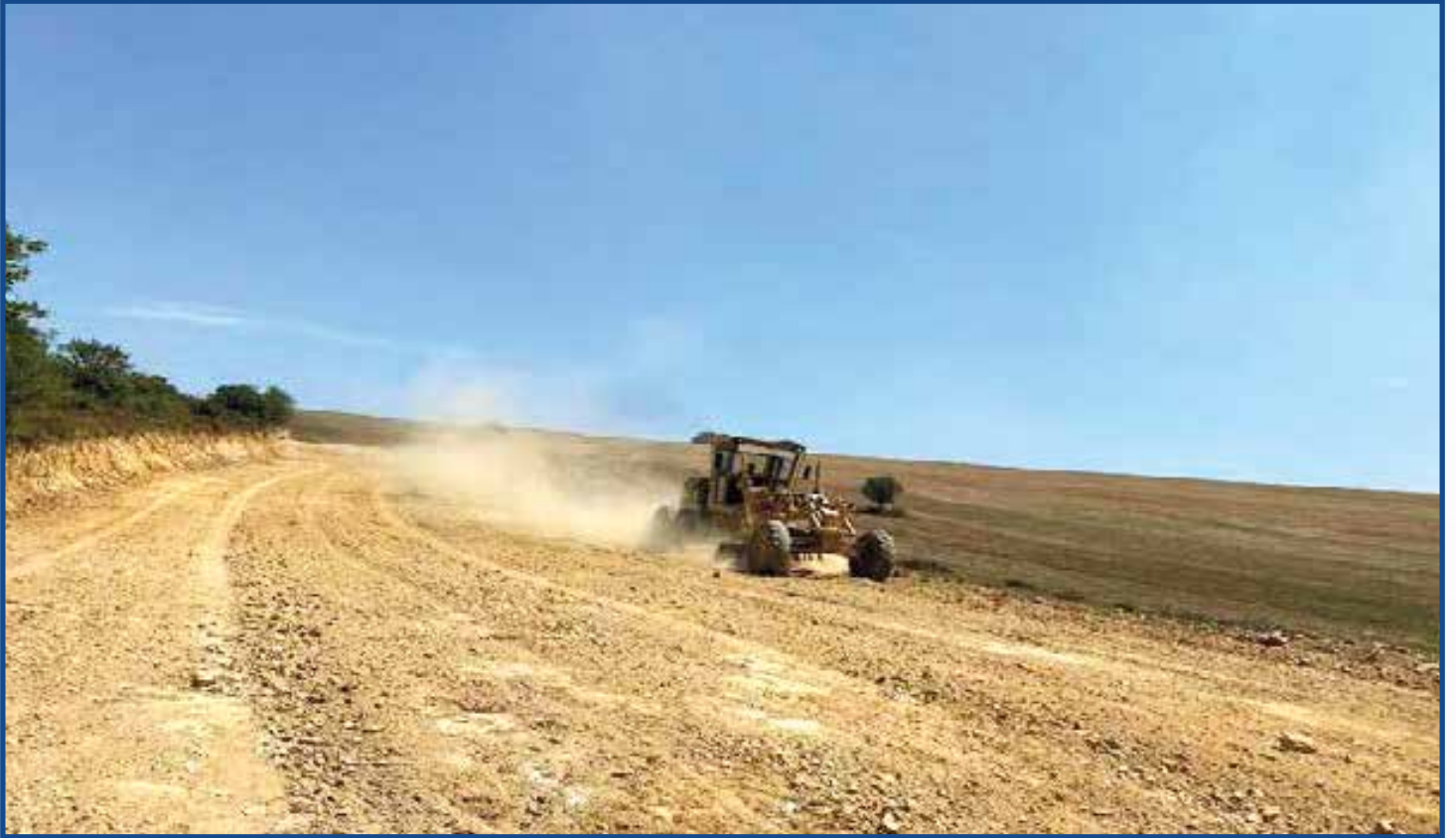
Mescit Mahallesi TOKİ Arka Yol
