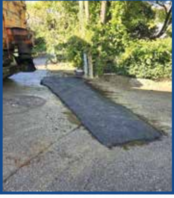
Aydınlı Mahallesi Ulus Sokak
