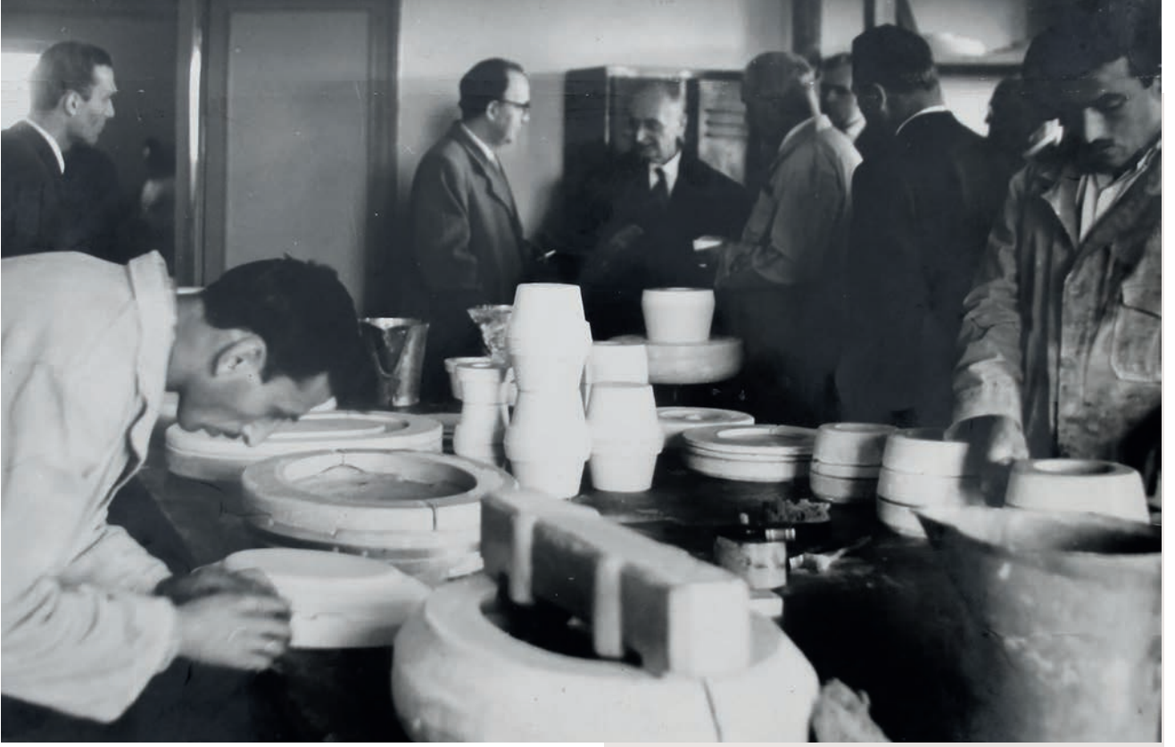
Tuzla'da 1963 yılında kurulan porselen fabrikası.
