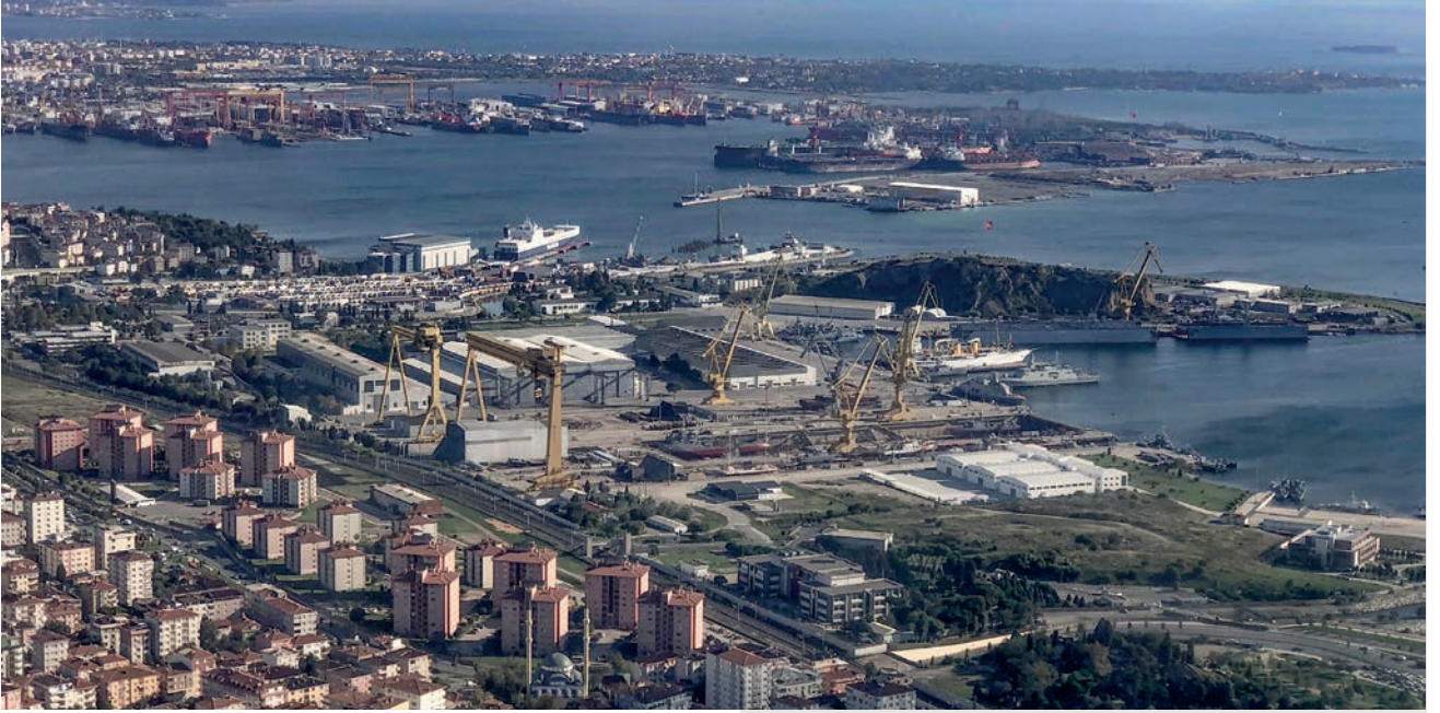
Tuzla tersaneler bölgesinin havadan görünümü. (Depo Photos)
