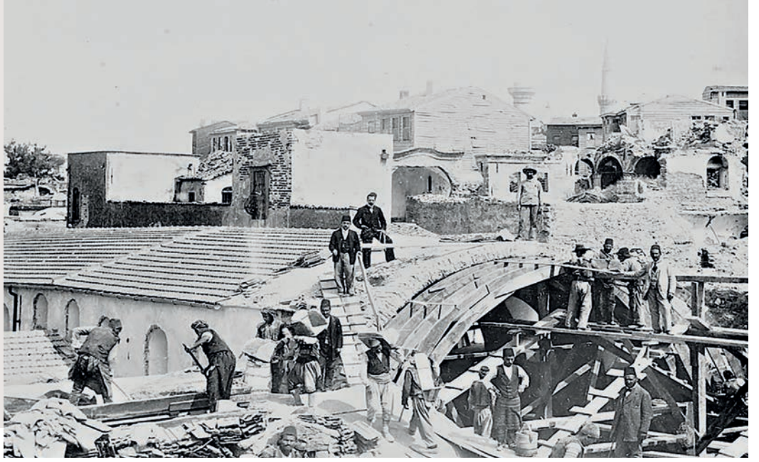
Yıkılan Kapalıcaşu Kalpakçılarbaşı Caddesi kemerinin onarımı, 1896.
