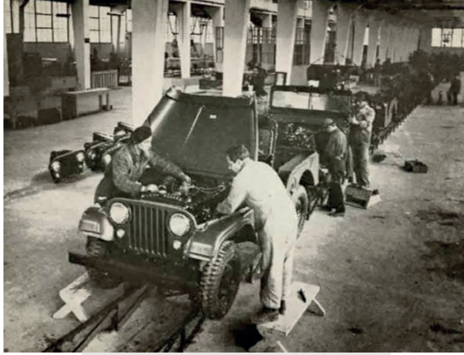
Tuzla'da 1954 yılında kurulan Cip Fabrikası.
